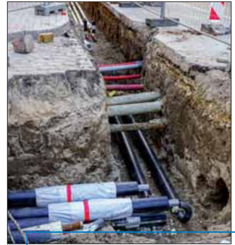
Neuverlegung einer Fernwärmeleitung
