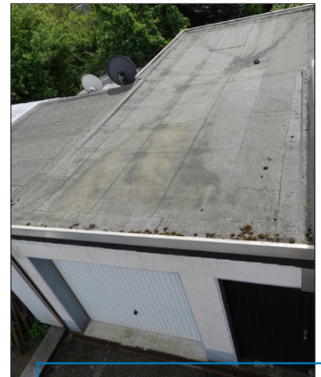
Flachdachabdichtung mit Bitumenschweißbahnen einer Garage.
