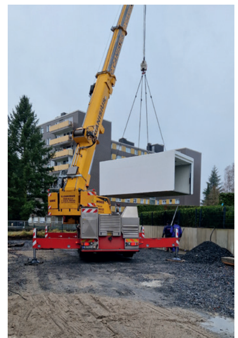
Aufstellung einer Fertigteilarage mit einem Autokran
