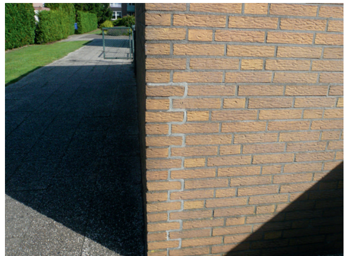
Nachträglich verfugter Eckbereich
