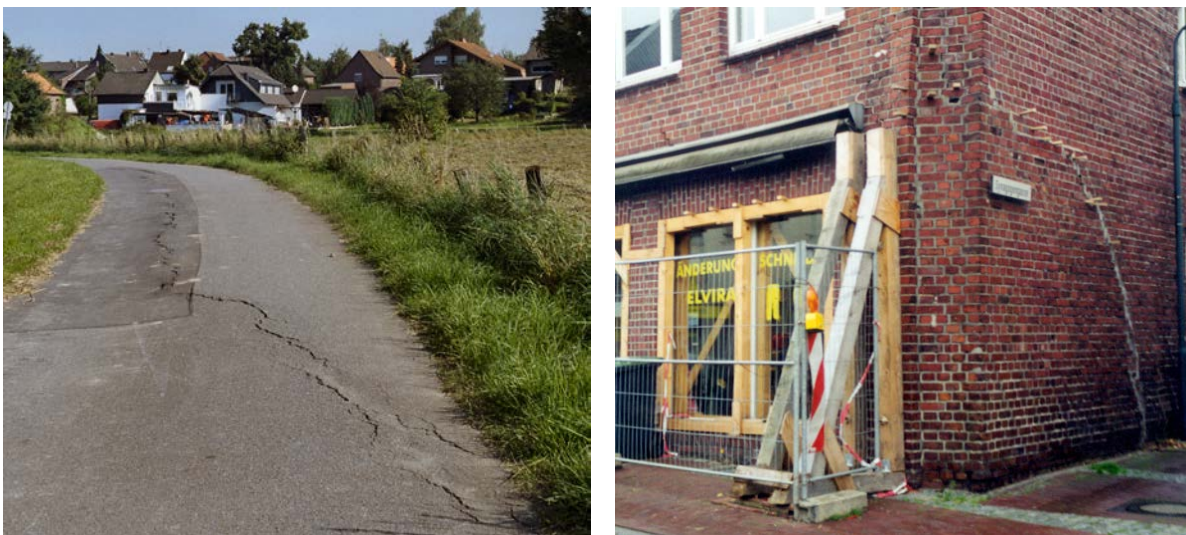
Abb. 1: Erdstufenbildung zwischen zwei Ortslagen und an einem Gebäude
