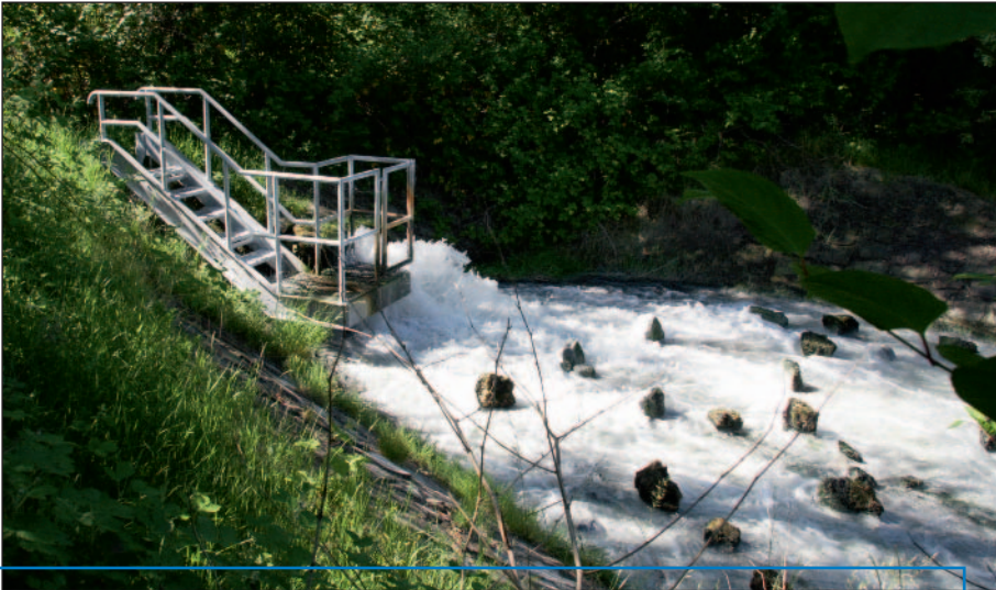
Grubenwassereinleitung in die Harpener Teiche aus dem Schacht Arnold der ehemaligen Zeche Robert Müser.
