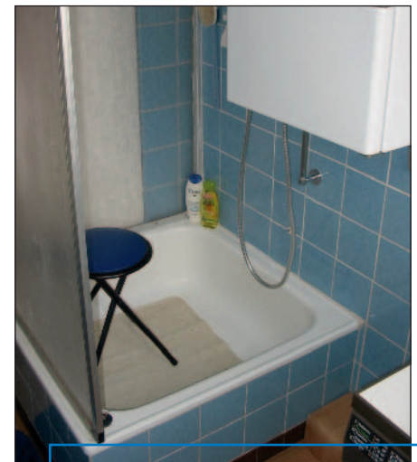
Duschtasse mit einer Einstiegshöhe von ca. 30 cm und eingeschränkter Bewegungsmöglichkeit durch die Gastherme.
