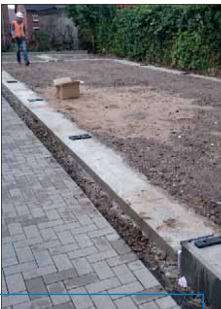
Fundamente für Fertiggaragen mit Höhenausgleichselementen.
