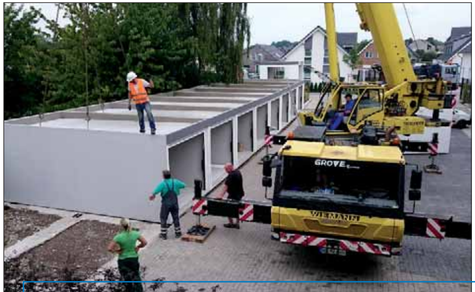
Aufstellen von Fertigaragen in einem Neubaugebiet mit einem Autokran.
