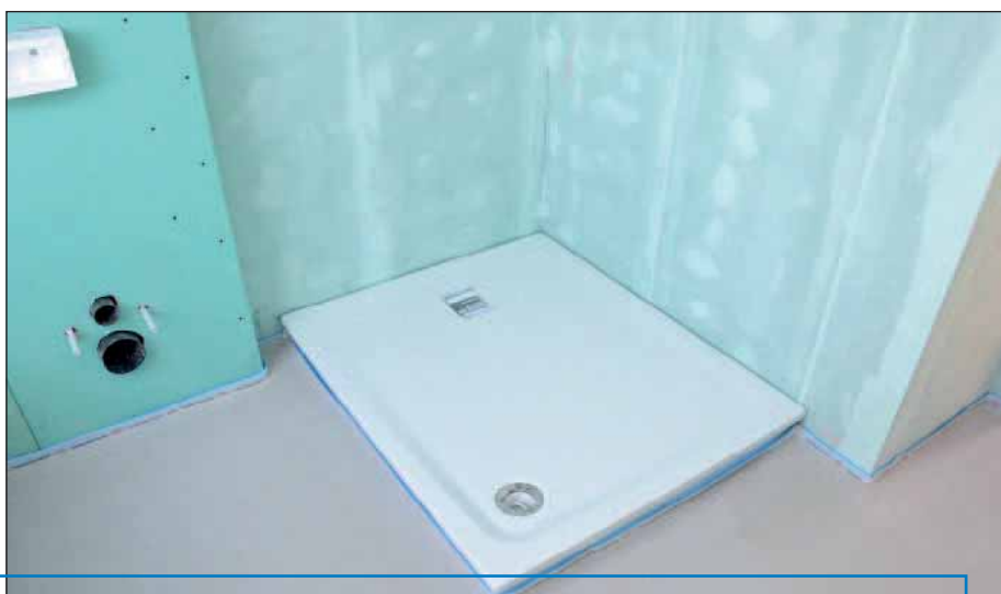
Bei Badsanierungen werden häufig für Feuchträume geeignete Gipskarton-Platten verwendet.
