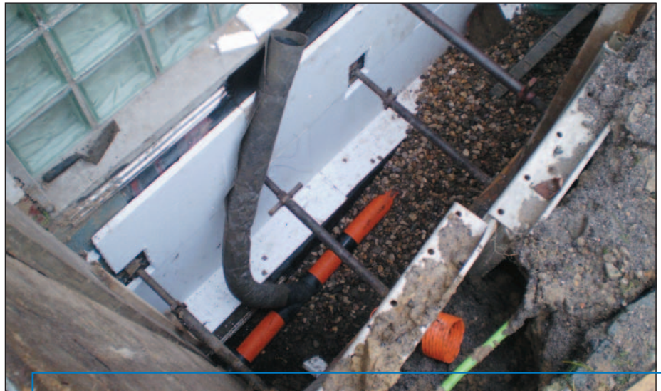
Drainageleitung in Siebkiespackung.
