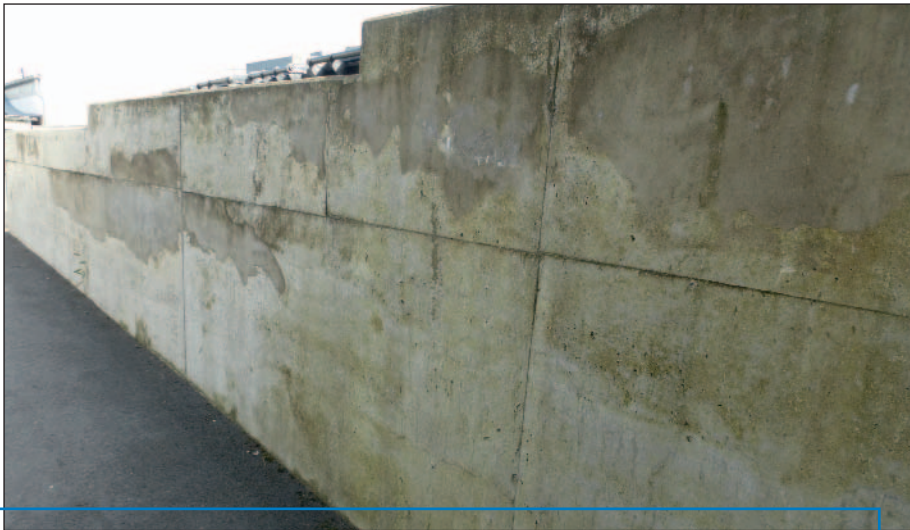
Nachbearbeitete Oberfläche einer Sichtbetonwand.
