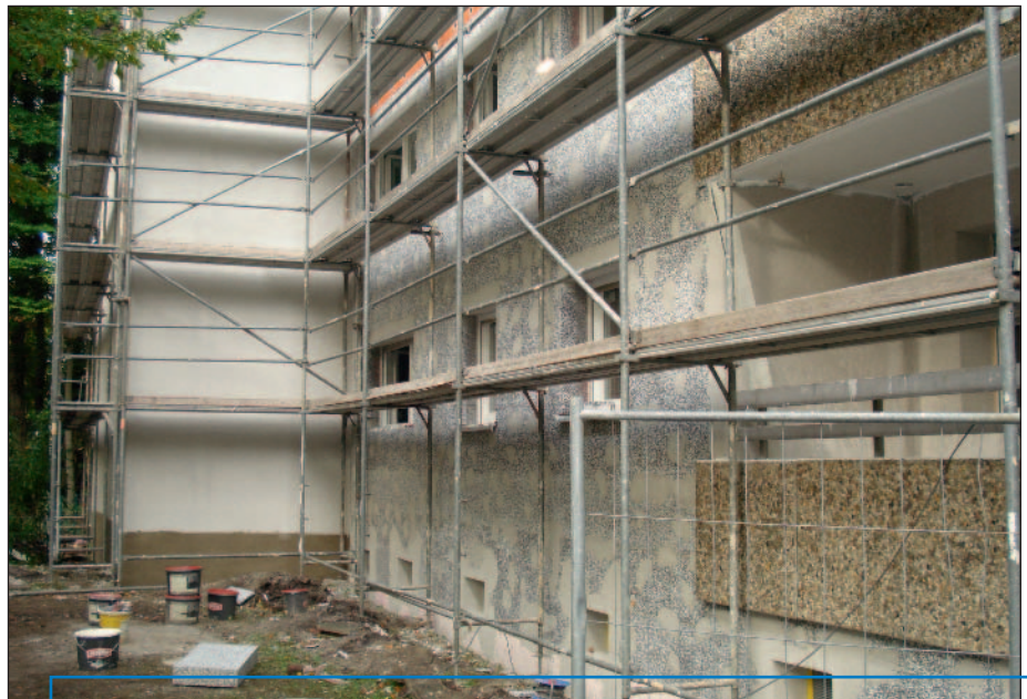
Einrichtung einer WDVS-Baustelle.
