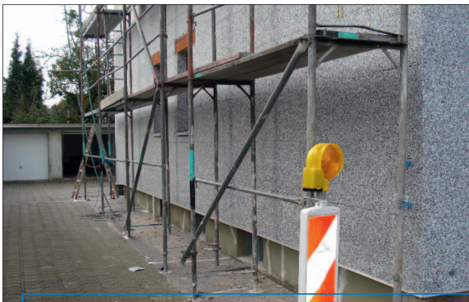
Fertiges Wärmedämm-Verbundsystem vor der Oberflächenbearbeitung.
