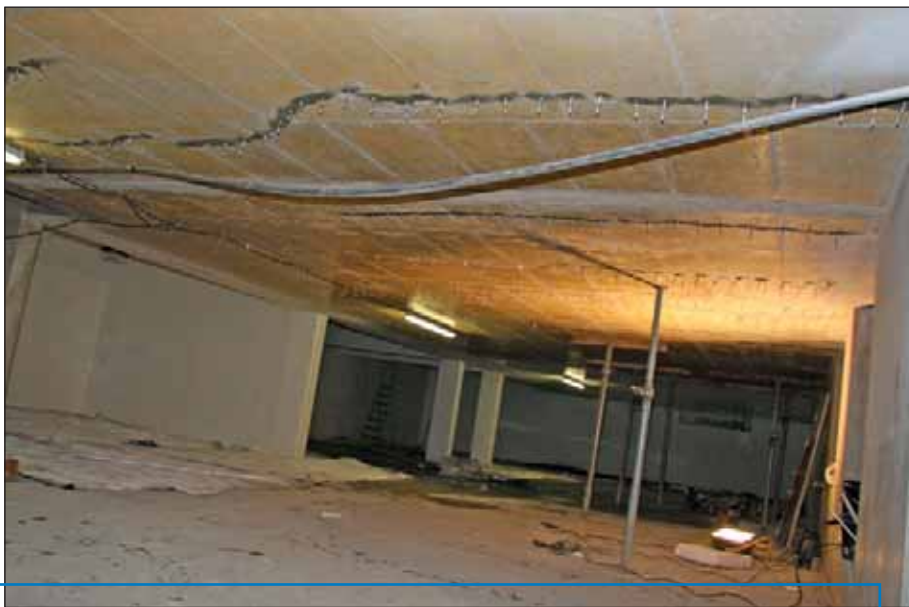
Rissverpressung bei einer Betondecke. Die sog. Schraubpacker werden später wieder entfernt und die Deckenansicht nachgearbeitet.
