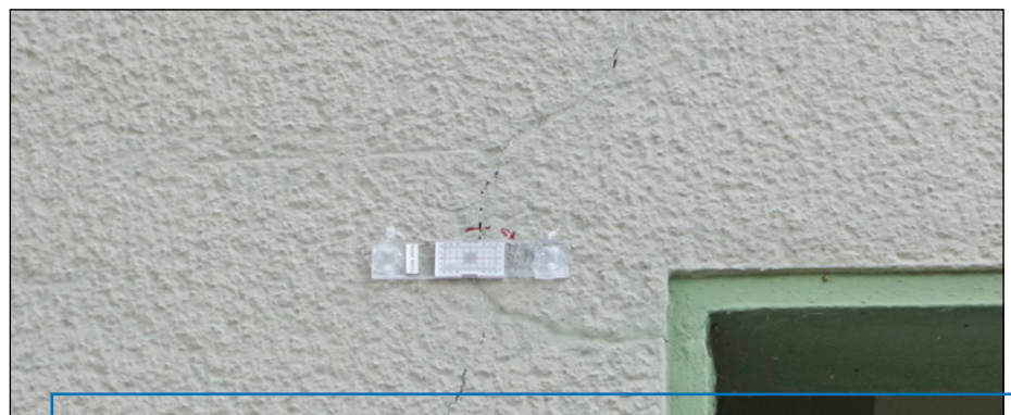
Markierung zur Kontrolle weiterer Gebäudebewegungen.
