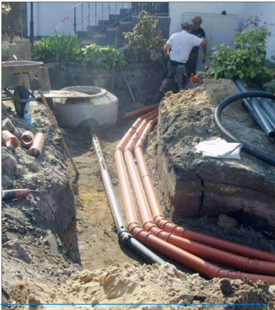
Zuleitungen zu einer Brunnenanlage und zur Elektrostation.
