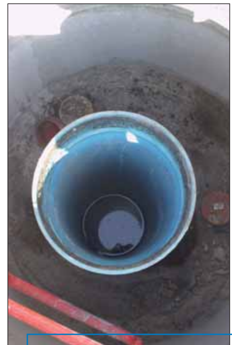
Schachtkopf einer Brunnenanlage.
