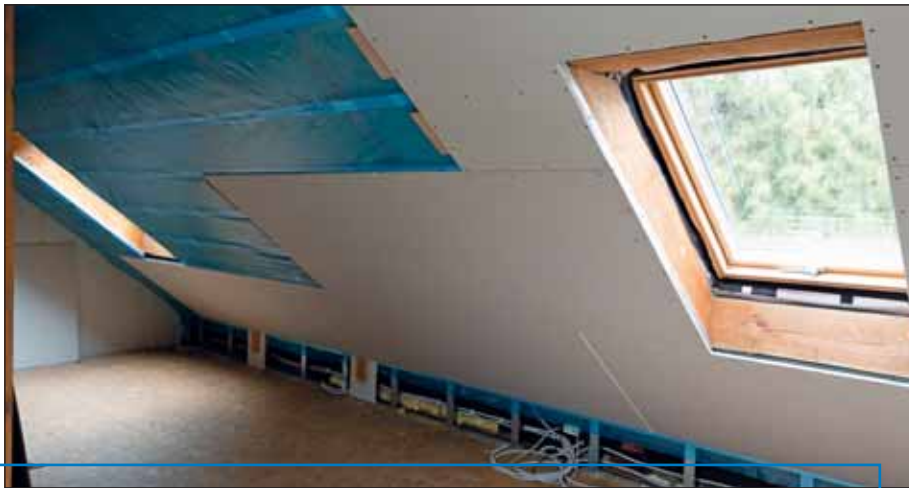
Klassischer Dachgeschossausbau mit Gipskartin-(Gk-)Platten.
