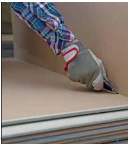
Zuschneiden einer Gk-Platte.
