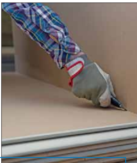
Zuschneiden einer Gk-Platte.
