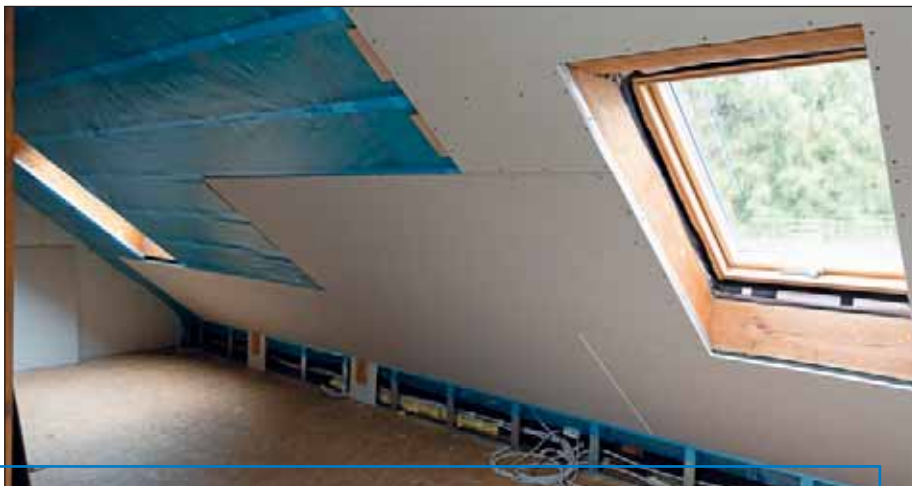
Klassischer Dachgeschossausbau mit Gipskarton-(Gk-)Platten.
