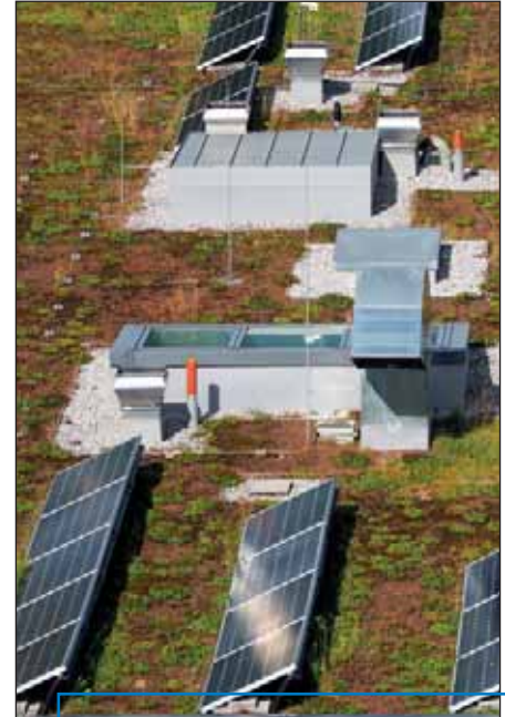
Optimiert: Dachbegrünung und Solaranlage.
