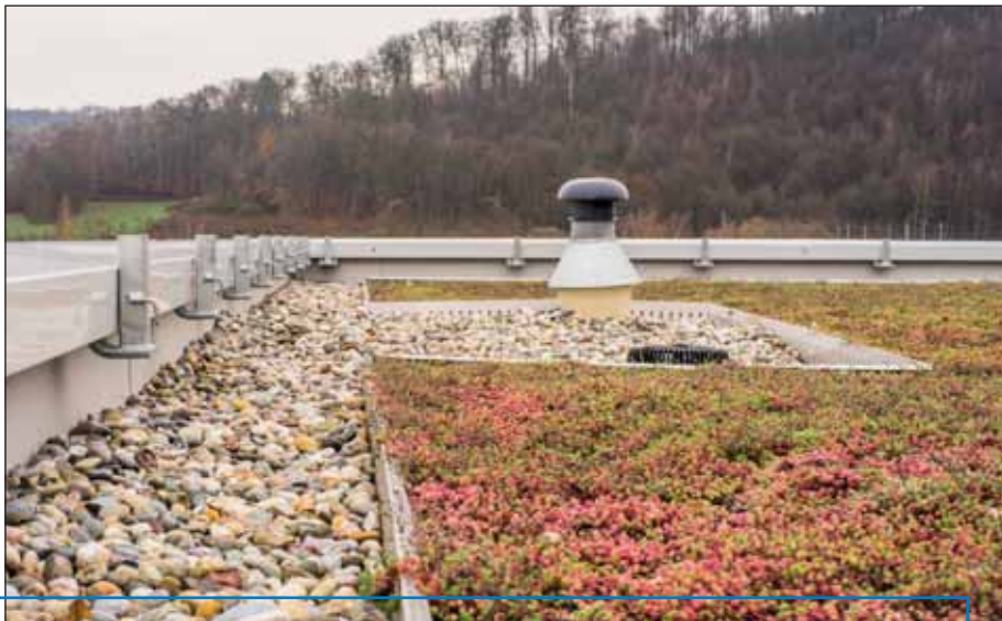
Häufig anzutreffen: Flachdach mit Begrünung.
