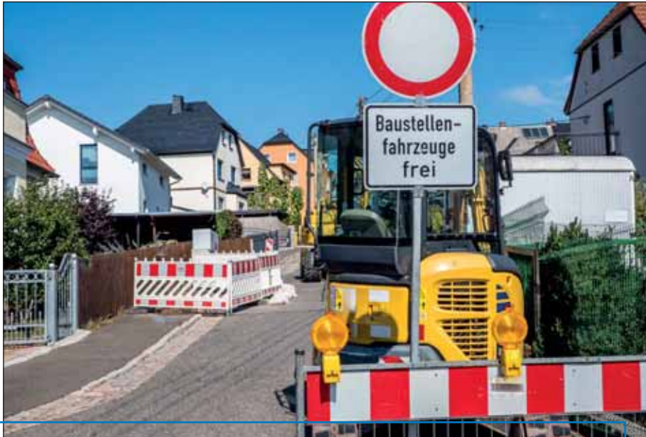
Bei einer Straßenreparatur werden Anlieger an den Kosten in unterschiedlicher Höhe beteiligt.
