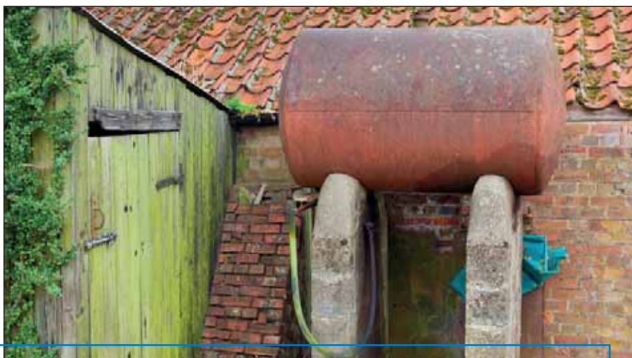
Diese Form der Ölbevorratung stellt mit Sicherheit eine Gefahr für die Umwelt dar.
