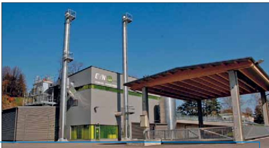
Außenansicht eines Biomasse-Fernheizwerks.
