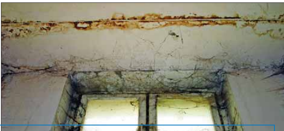
Freiliegender Bewehrungsstahl in einer Kellerdecke. Hier ist Sanierung anstelle Kosmetik gefragt.
