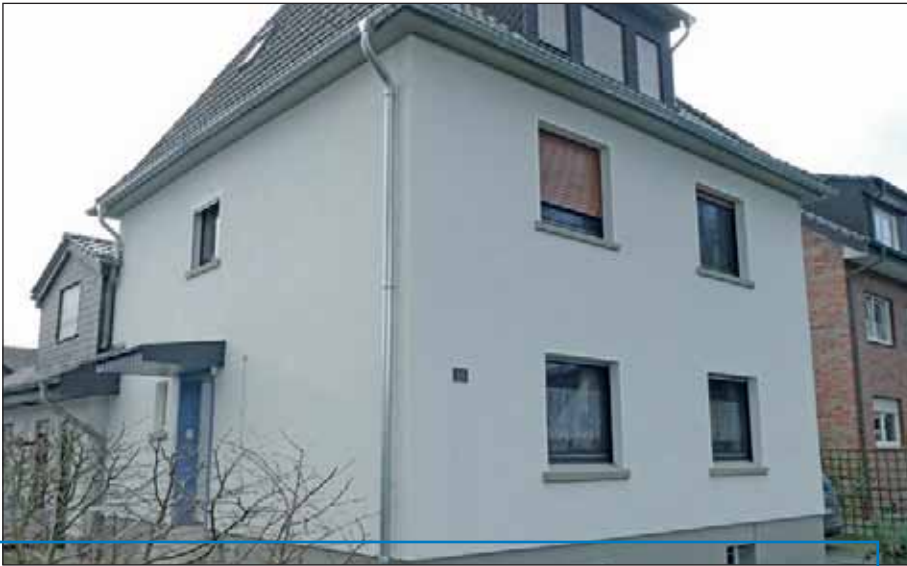
Erneuerte Fassade mit einem Wärme-Dämm-Verbundsystem.
