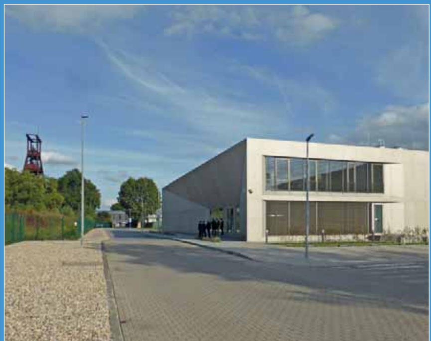
Die Grubenwasserhaltung für die ehemaligen Standorte der RAG wird seit dem letzten Jahr in der zentralen Leitwarte auf dem Gelände der ehemaligen Zeche Pluto in Herne kontrolliert.
