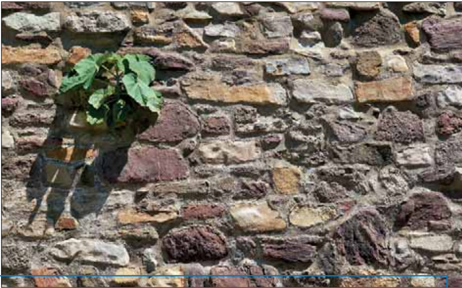
Dem Fugenmaterial dieser alten Natursteinmauer scheint nichts anhaben zu können.
