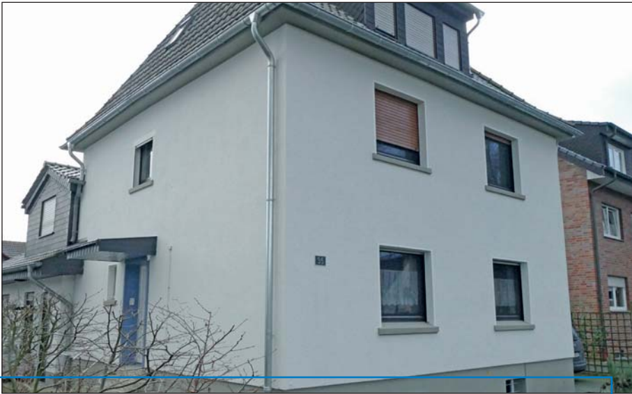
Erneuerte Fassade mit einem Wärme-Dämm-Verbundsystem.
