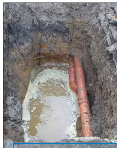
Grundleitungssanierung in offener Bauweise.
