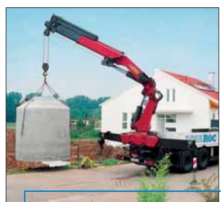
Anlieferung einer Zisterne aus Beton.
