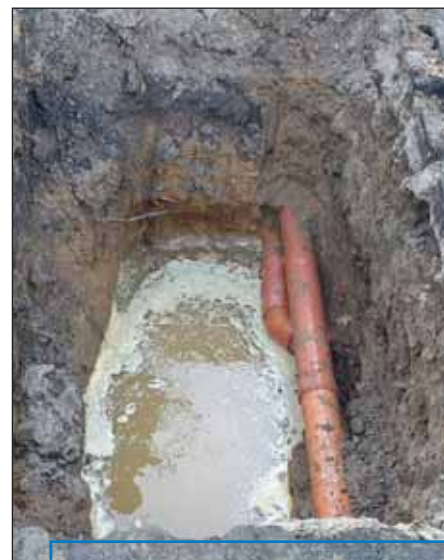
Grundleitungssanierung in offener Bauweise.
