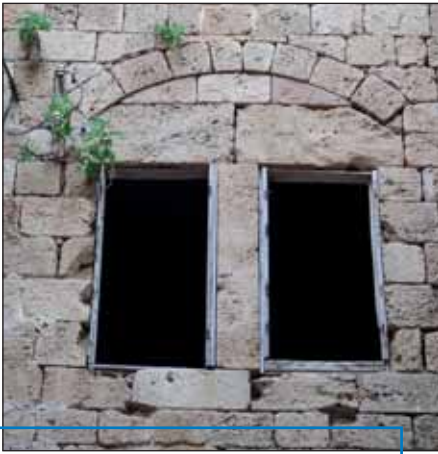
Historischer Segmentbogen aus Trockenmauerwerk.
