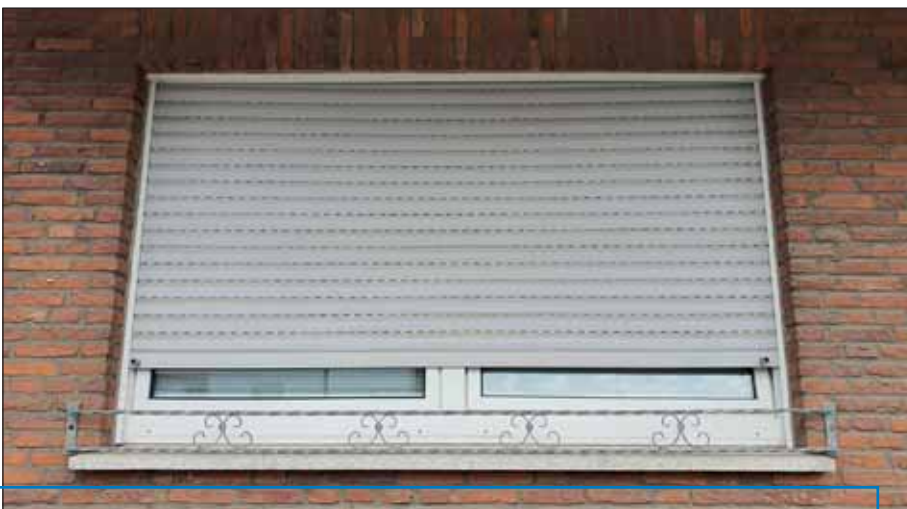
Fenstersturz als scheinbarer Bogen mit einer Spannweite von rd. 2,00 m.
