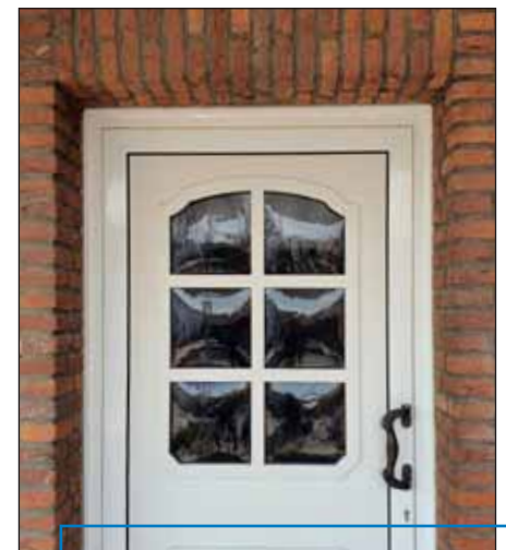
Türsturz als scheinrechter Bogen mit kurzer Spannweite.
