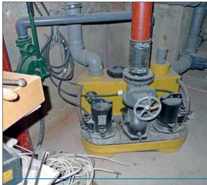
Fäkalienhebeanlage.
