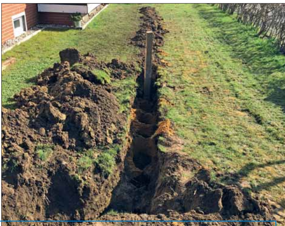
Anlage eines Entspannungsgrabens.
