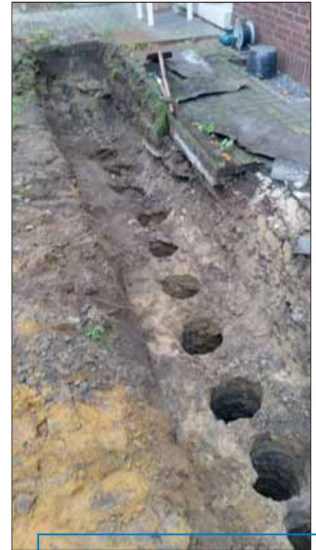
Entspannungsbohrungen vor der Torfverfüllung.
