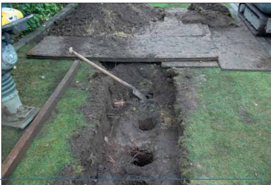
Anlage eines Entspannungsgrabens mit Torfbohrungen.
