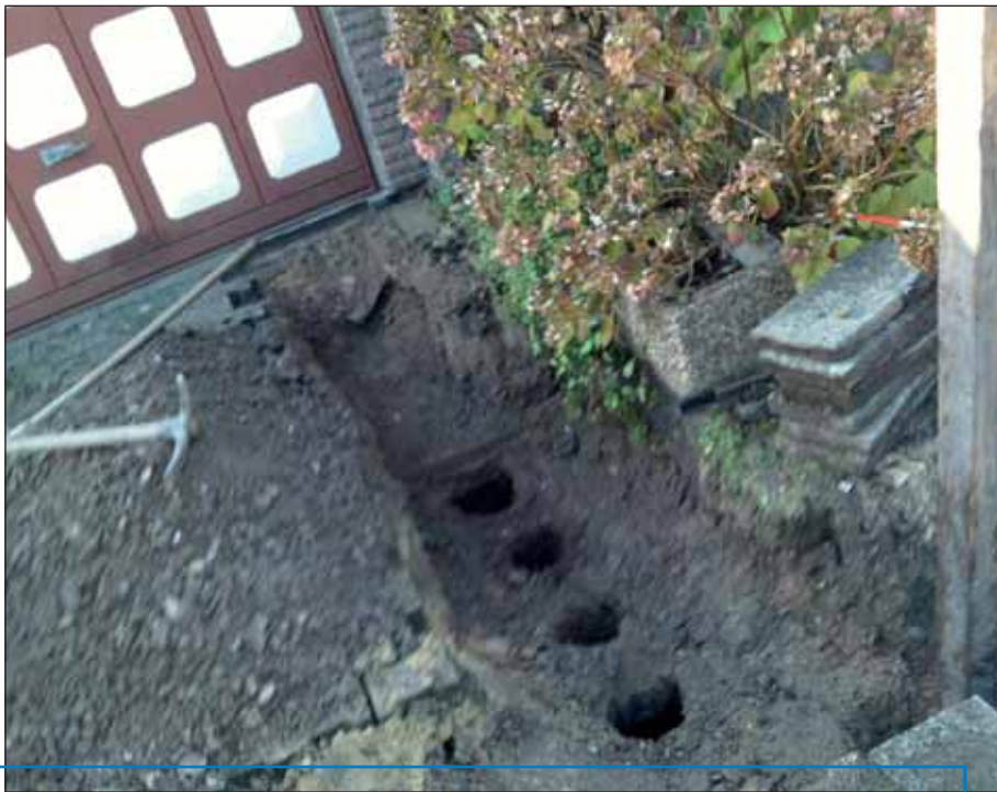
Vorbereitung eines Entspannungsgrabens mit Bohrungen für Torfpolster.
