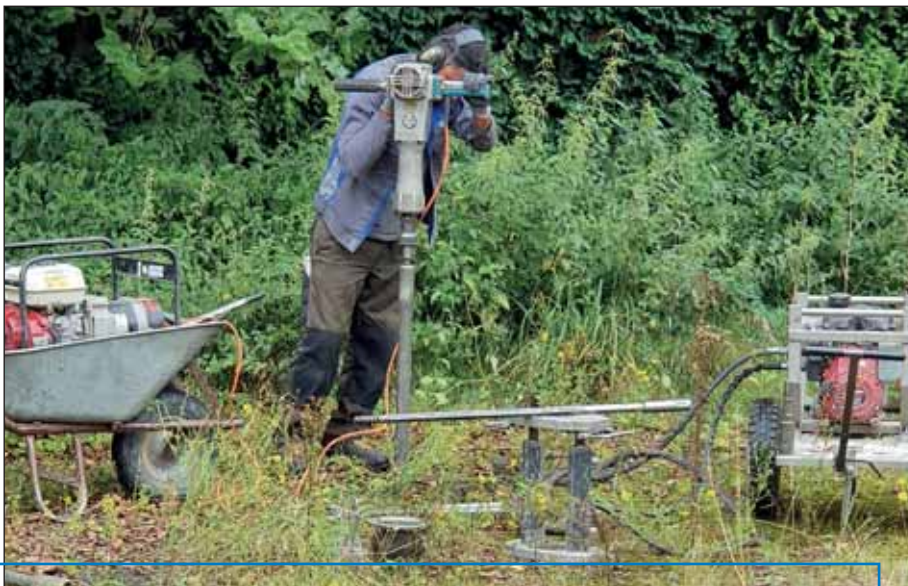
Bohrerüst für Kleinrammbohrung.
