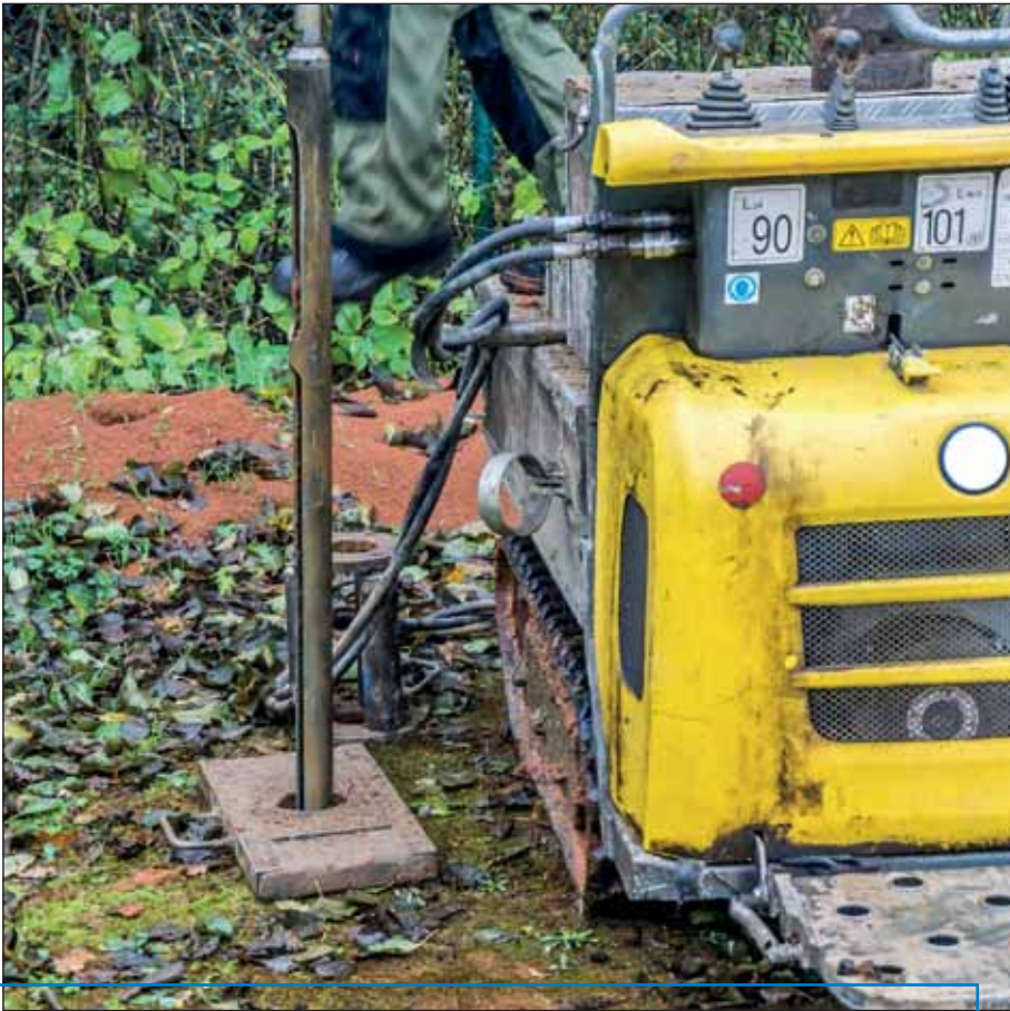
Kleine Pfahlbohrmaschine zur Untersuchung des Untergrundes und der Bodenschichten.
