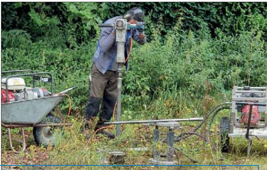
Bohrerüst für Kleinrammbohrung.
