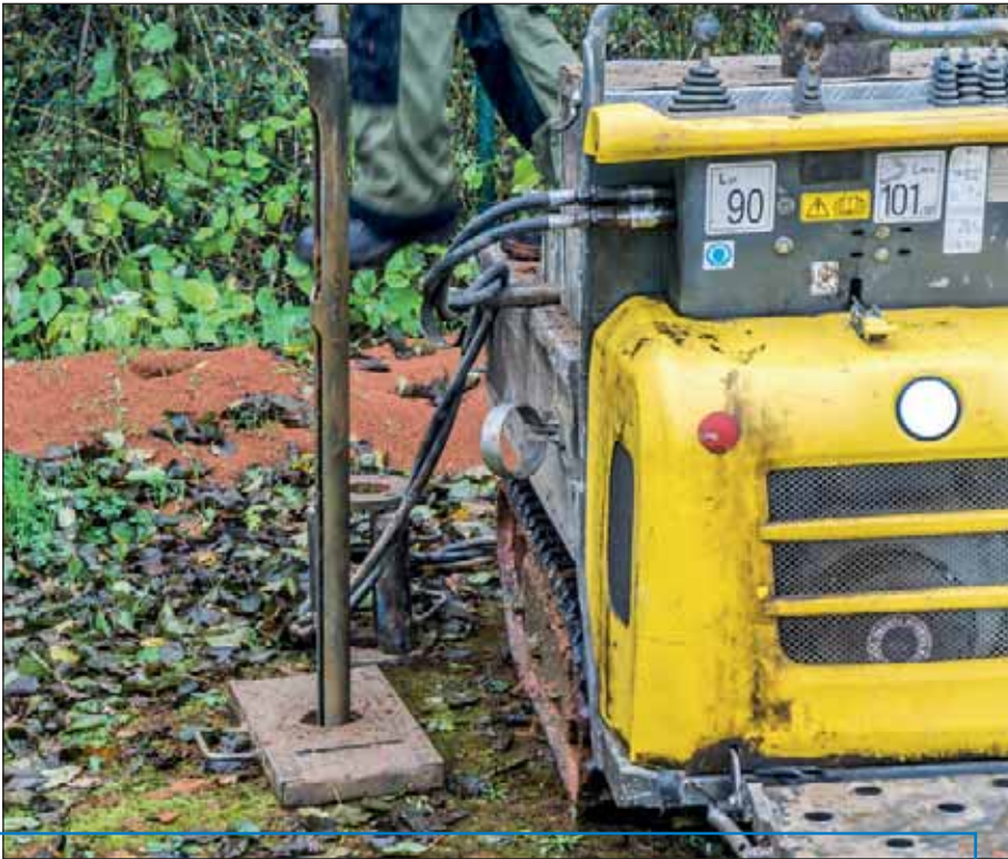
Kleine Pfahlbohrmaschine zur Untersuchung des Untergrundes und der Bodenschichten.
