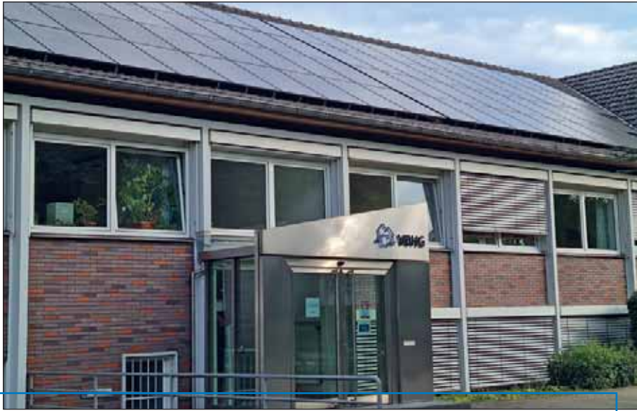
Die aktuell fertiggestellte Photovoltaik-Anlage auf dem Dach des VBHG-Bürogebäudes in Herten deckt bei Sonnenschein einen großen Teil des Strombedarfs des Bürobetriebs.
