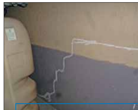
Verpresster Riss, bereits nachbearbeitet.
