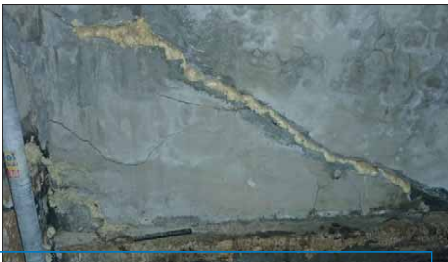
Kraftschlüssig verpresster Riss noch vor der Endbearbeitung.
