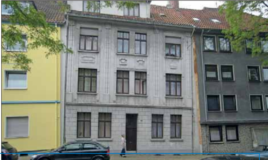
Bergbaubedingte Schiefstellungen führen zu einem Minderwertanspruch.
