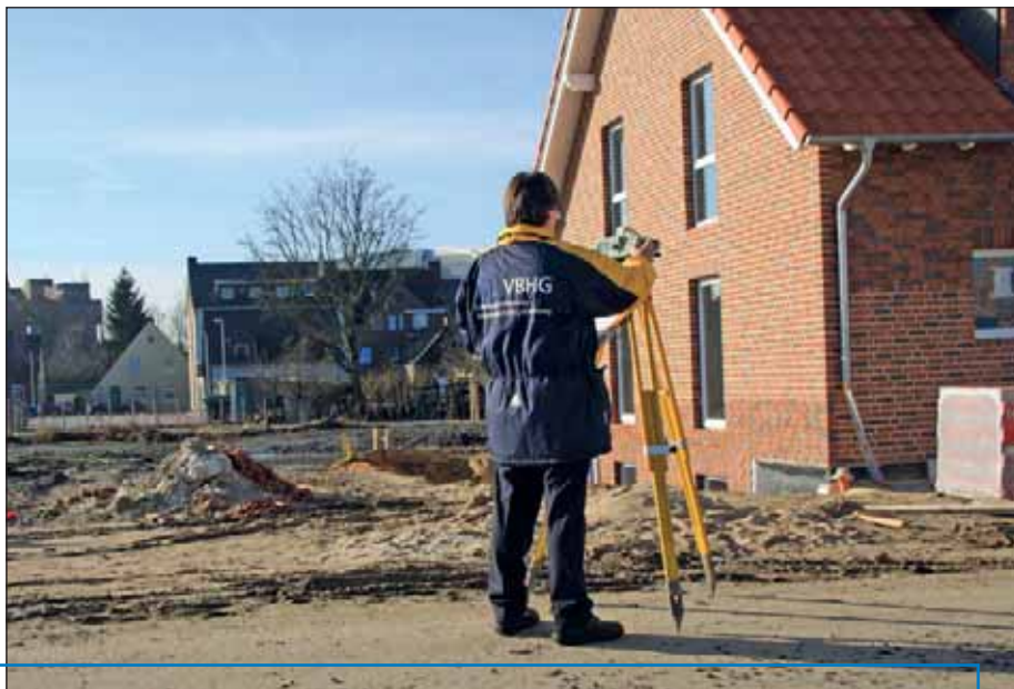
Ersteinmessung (Ursprungsmessung) eines Wohnhauses durch den VBHG.
