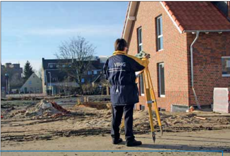
Ersteinmessung (Ursprungsmessung) eines Wohnhauses durch den VBHG.
