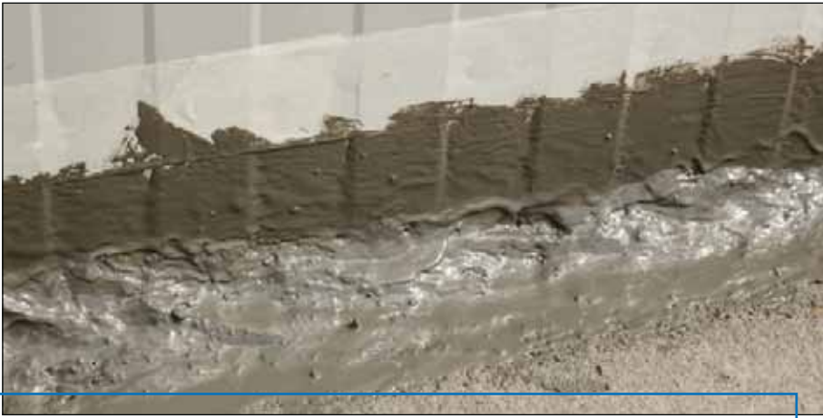
Erste Schicht eines frisch aufgetragenen Abdichtungsmaterials auf einer äußeren Wand-Boden-Verbindung.
