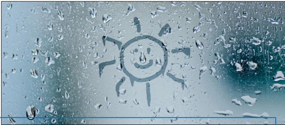
Schwitzwasser auf Fensterscheiben zeugt von hoher Luftfeuchtigkeit.
