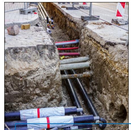
Neuverlegung einer Fernwärmeleitung
