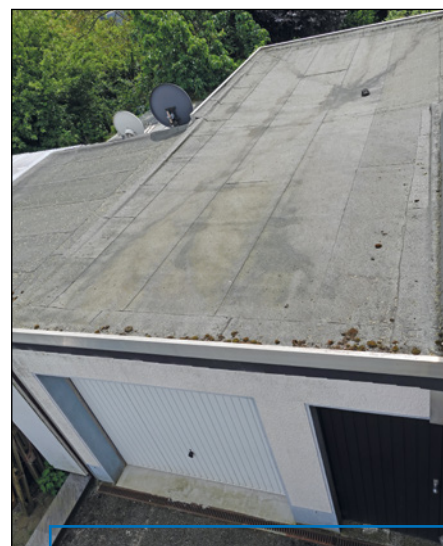
Flachdachabdichtung mit Bitumenschweißbahnen einer Garage.
