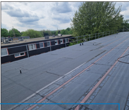
Zweilagige Flachdachabdichtung mit Bitumenbahnen oberhalb der Gefälledämmung. Für spätere Wartungsarbeiten wurden Sekuranten zur Personensicherung integriert.
