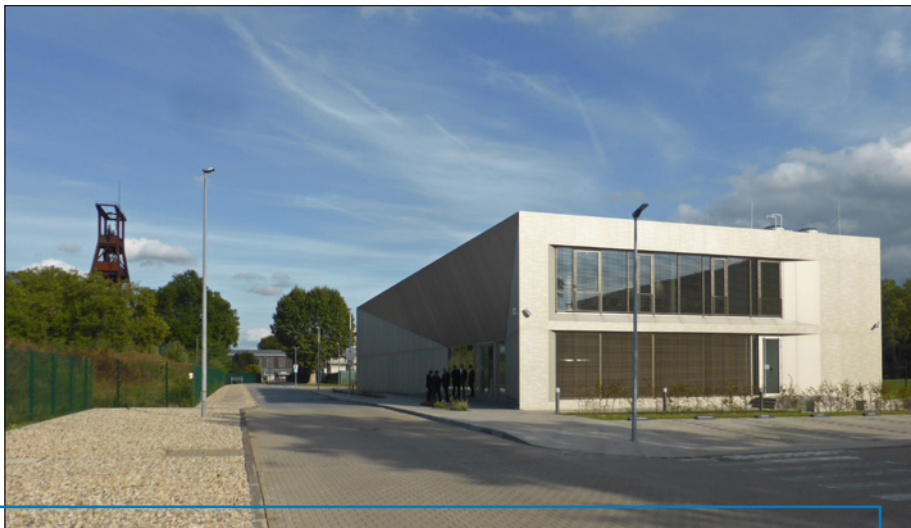
Grubenwasser-Leitwarte auf dem ehemaligen Zechenstandort Pluto in Herne.
