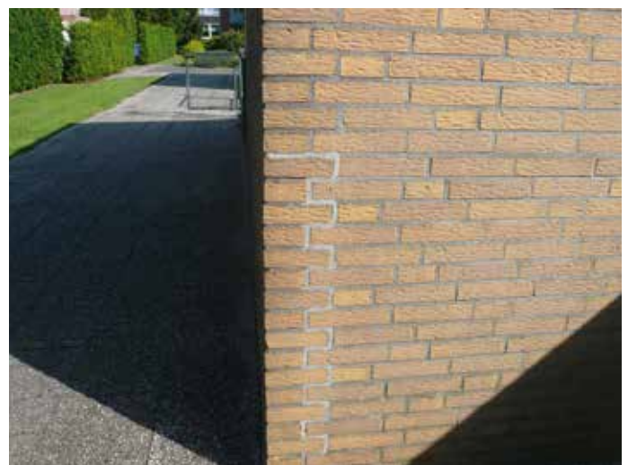
Nachträglich verfugter Eckbereich
