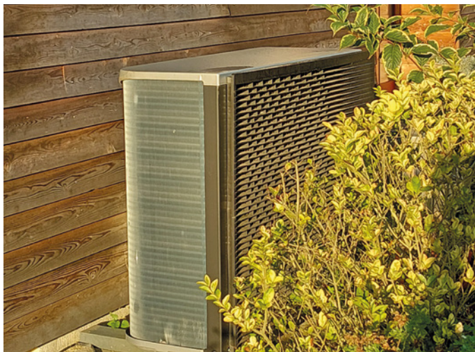
Luftwärmepumpe
