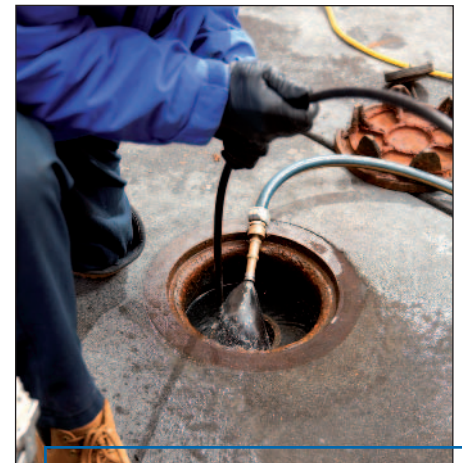
Kamerainspektion einer privaten Abwasserleitung.
