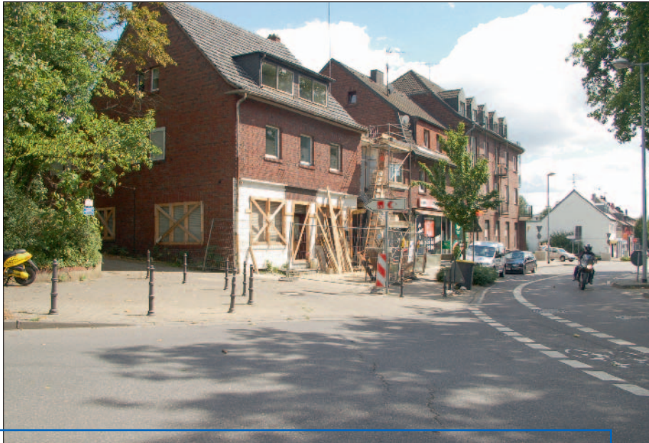
Totalschaden in Hückelhoven. Im Vordergrund ist die Störungszone sichtbar.
